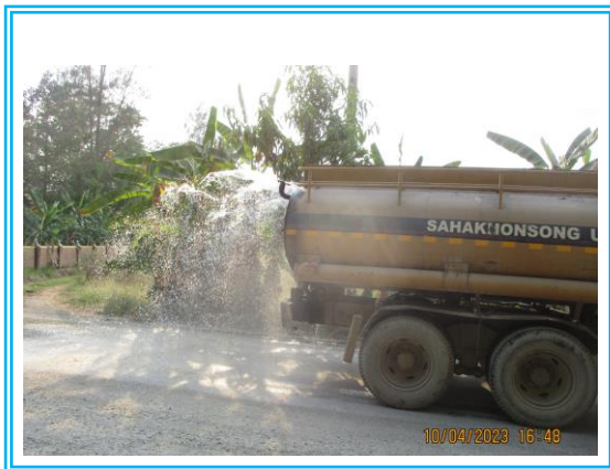
รูปที่ 3-11 ฉีดพรมน้ำตามเส้นทางขนส่งแร่
